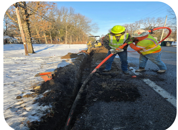
Coupling of Conduit
