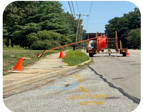
Pulling Back of Conduit
