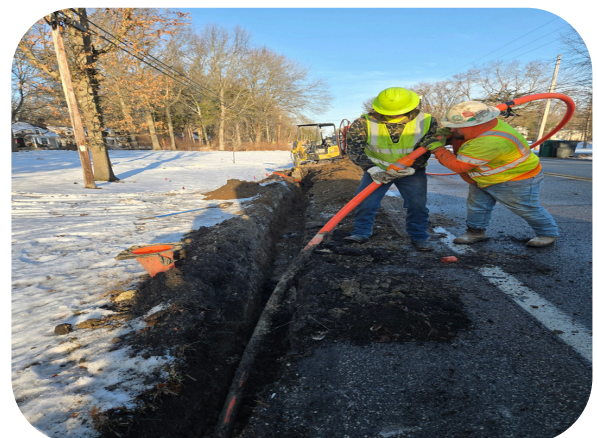
Coupling of Conduit
