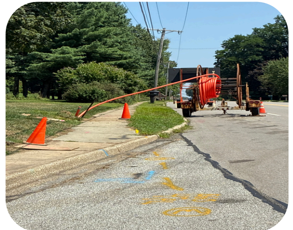
Pulling Back of Conduit
