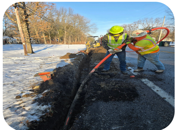
Coupling of Conduit
