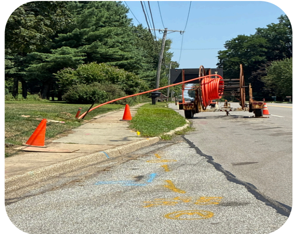
Pulling Back of Conduit
