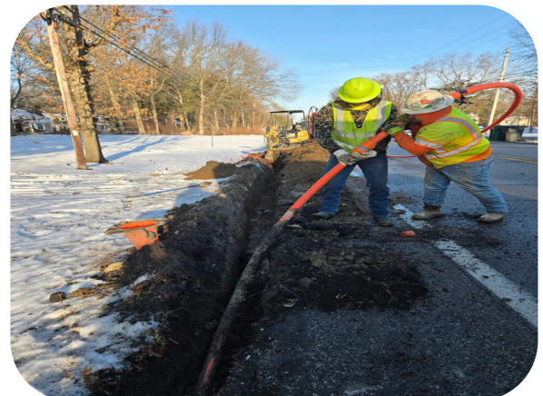
Coupling of Conduit
