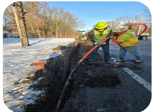
Coupling of Conduit
