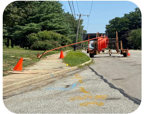
Pulling Back of Conduit
