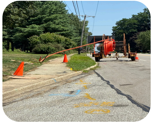
Pulling Back of Conduit
