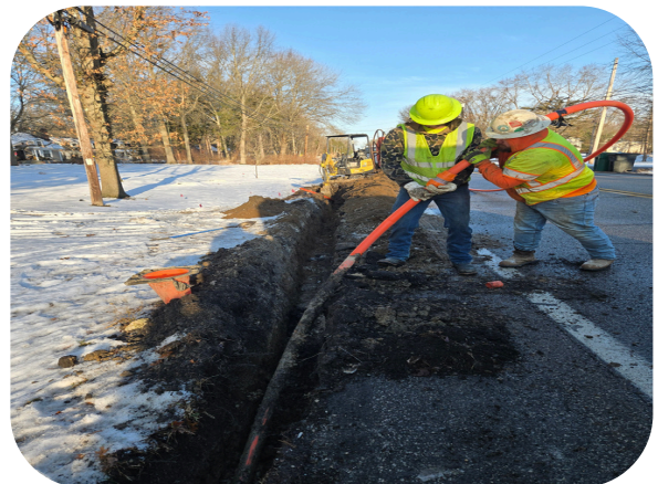
Coupling of Conduit
