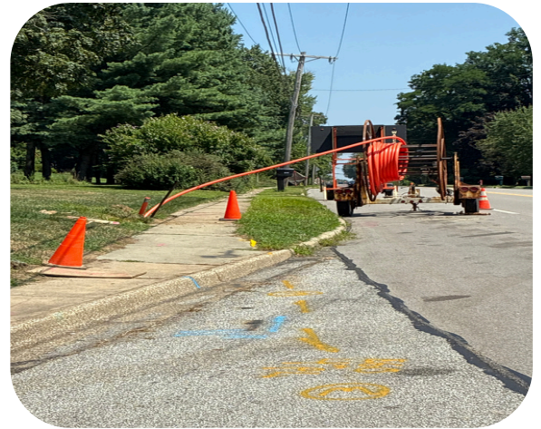
Pulling Back of Conduit
