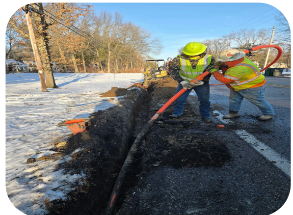
Coupling of Conduit
