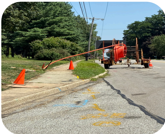
Pulling Back of Conduit
