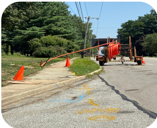
Pulling Back of Conduit
