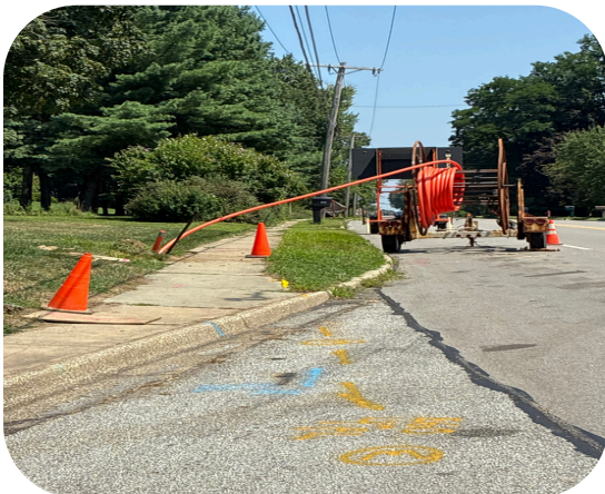
Pulling Back of Conduit
