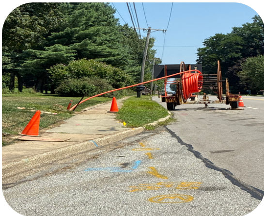
Pulling Back of Conduit
