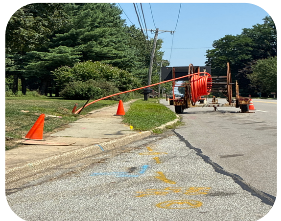
Pulling Back of Conduit
