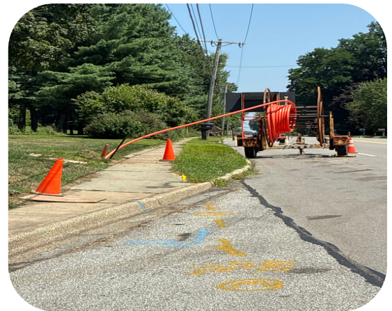
Pulling Back of Conduit
