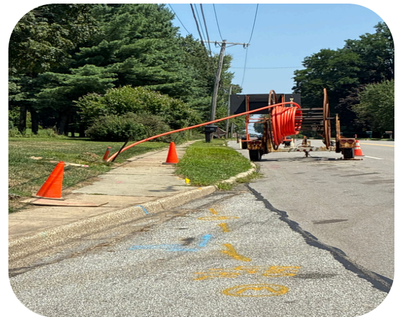
Pulling Back of Conduit
