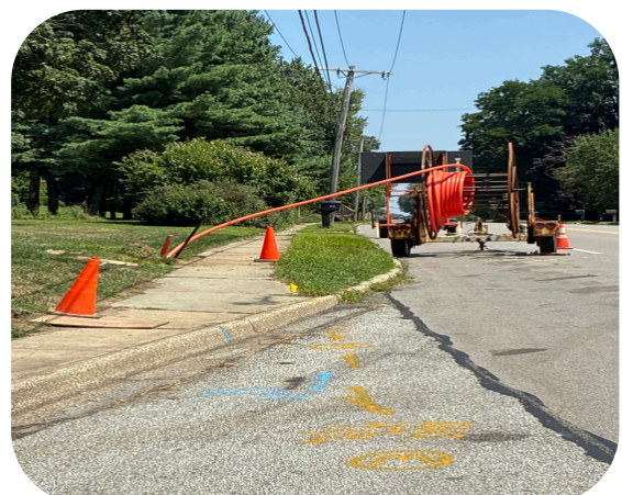
Pulling Back of Conduit
