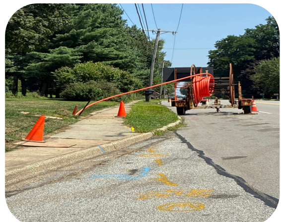
Pulling Back of Conduit
