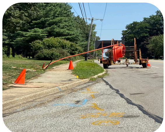
Pulling Back of Conduit
